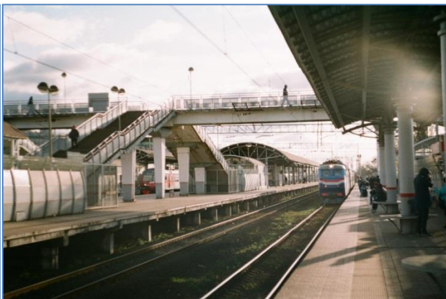
Железнодорожная станция «Раменское»
