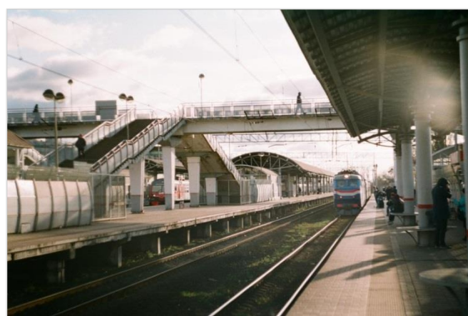
Железнодорожная станция «Раменское»
